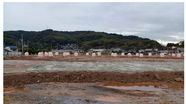
<第二期工事：試運転コース>
